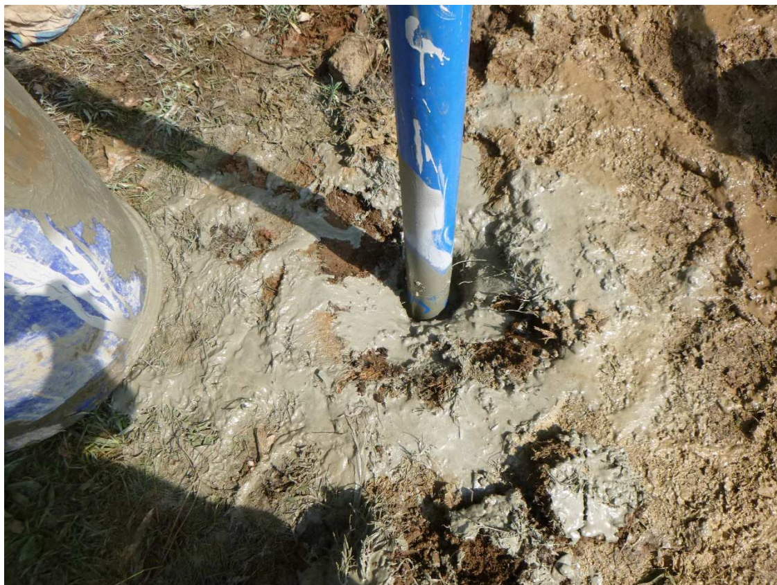
S 1: cementazione tubo Down-Hole
