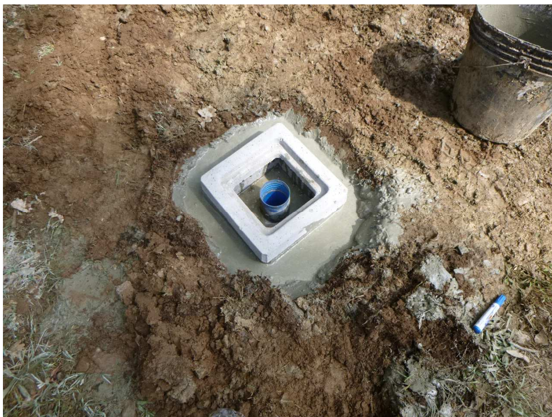
S 1: pozzetto protettivo i cls carrabile
